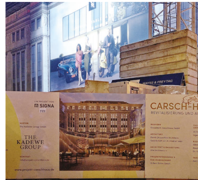
Baustelle Carch-Haus in Düsseldorf Archivfoto: Detlef Fleischer
